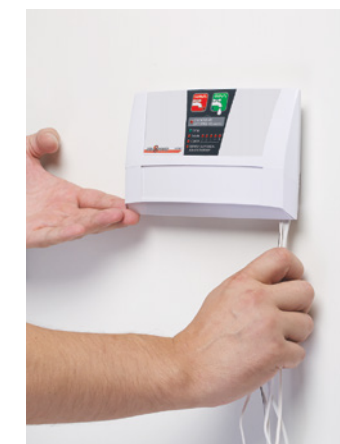
Навесить контроллер на пластину.
