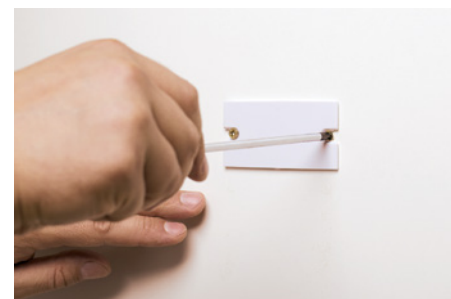
Просверлить отверстия для двух винтов (саморезов), прикрутить к стене пластину.
